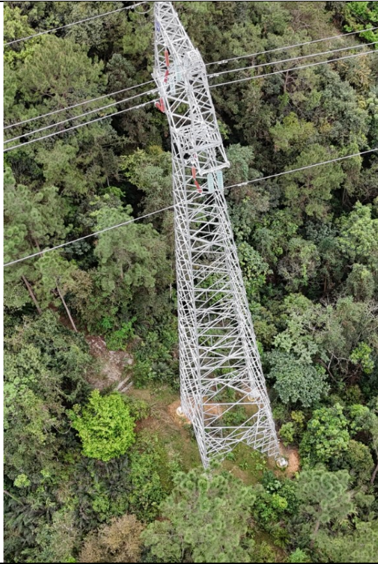
新建杆塔 C2 远景
