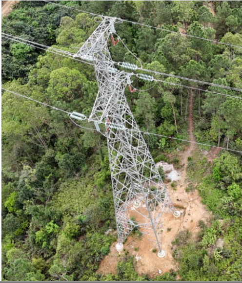
新建杆塔 C1 远景
