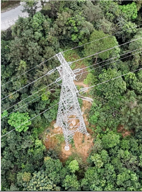
新建杆塔 C3 远景
