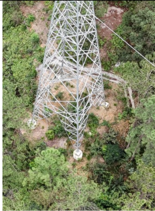
新建杆塔 C8 塔基近景
