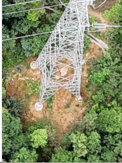
新建杆塔 C3 塔基近景
