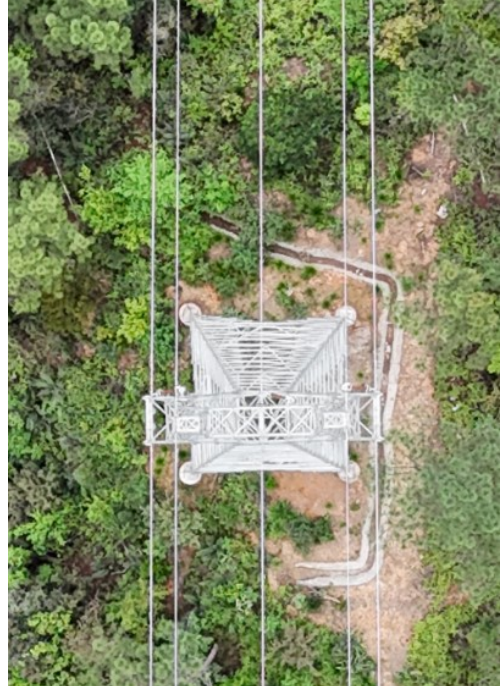
新建杆塔 C5 塔基近景
