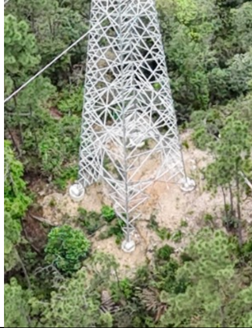
新建杆塔 C7 塔基近景
