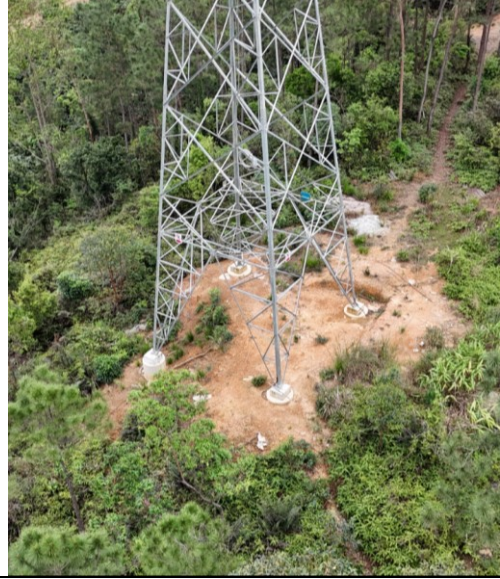
新建杆塔 C1 塔基近景
