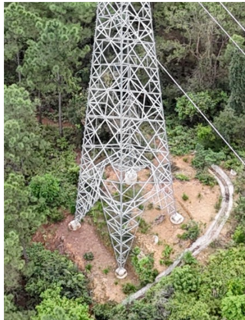
新建杆塔 C4 塔基近景
