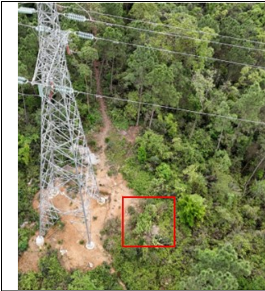
原 51#杆塔塔基处
