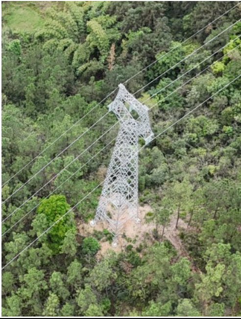
新建杆塔 C7 远景
