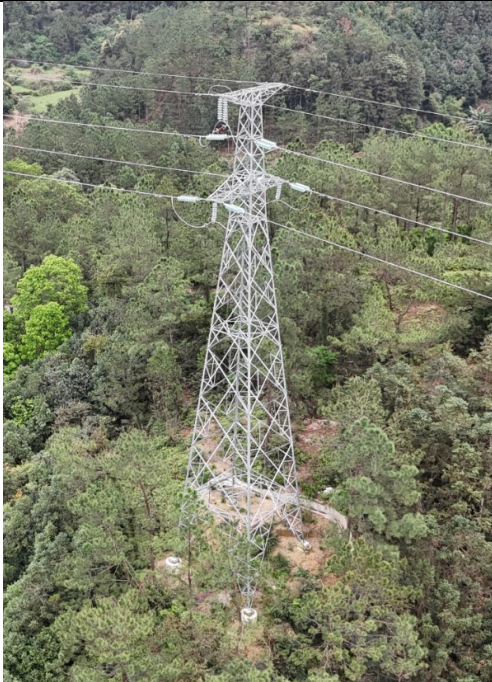
新建杆塔 C8 远景
