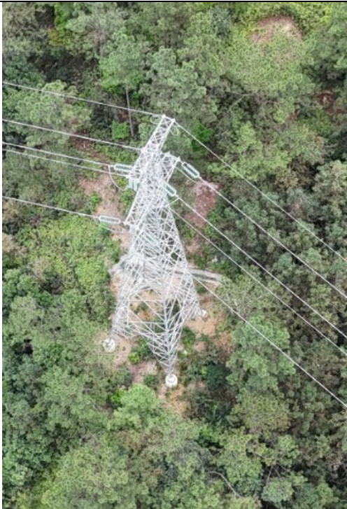
新建杆塔 C6 远景
