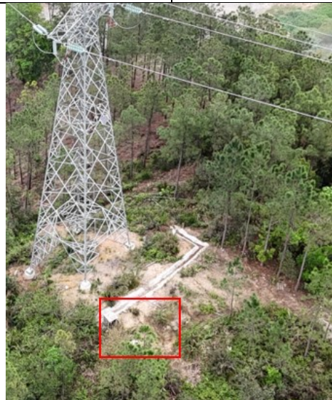
原 55#杆塔塔基处
