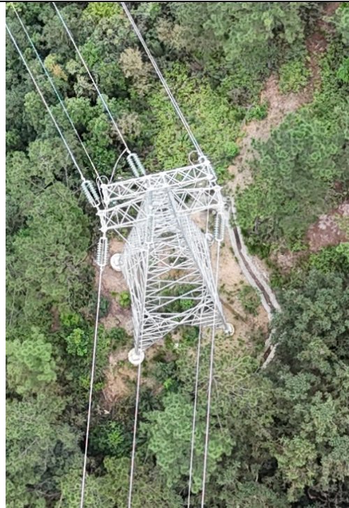
新建杆塔 C6 塔基近景
