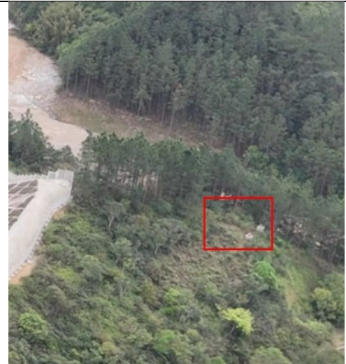
原 54#杆塔塔基处
