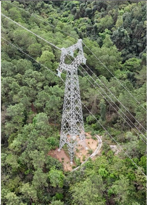
新建杆塔 C4 远景
