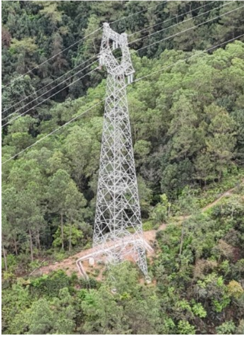
新建杆塔 C5 远景
