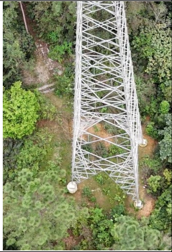
新建杆塔 C2 塔基近景
